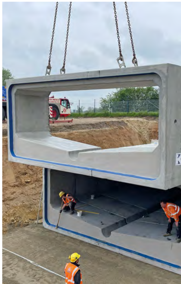
Die einzelnen Bauteile haben ein Maß von 7,7 m x 1,92 m x 3,4 m.
