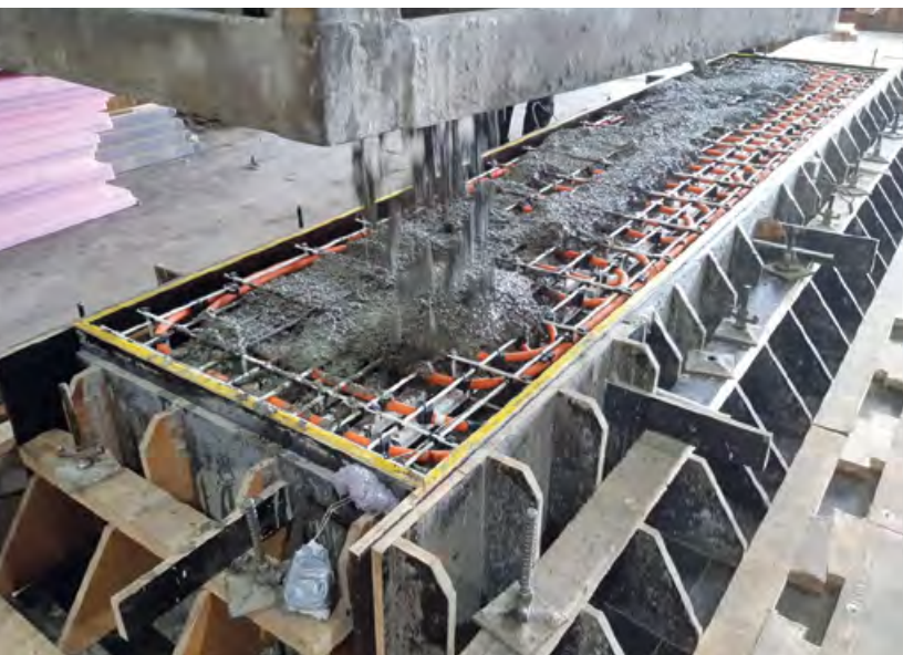
Herstellung eines Fertigteilmoduls mit integrierter Spule.
