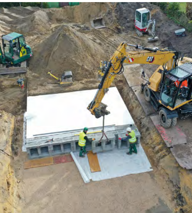
beDrain® Versickerungsblöcke mit geringer Einbautiefe – direkt unter der Pflasteroberfläche.
