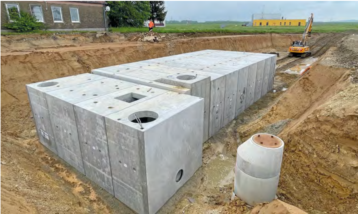
Hinter dem Stauraumkanal befindet sich ein Drosselbauwerk, das aus vier Rechteckprofilen zusammengesetzt wurde.
