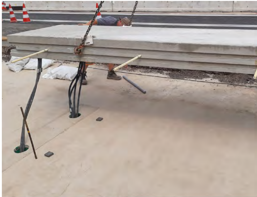
Verlegung eines Fertigteilmoduls.
