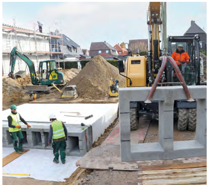
beDrain® Versickerungsblöcke mit geringer Einbautiefe – direkt unter der Pflasteroberfläche.
