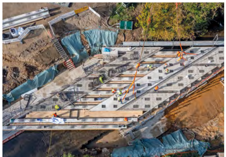
Montage des Überbaus.
