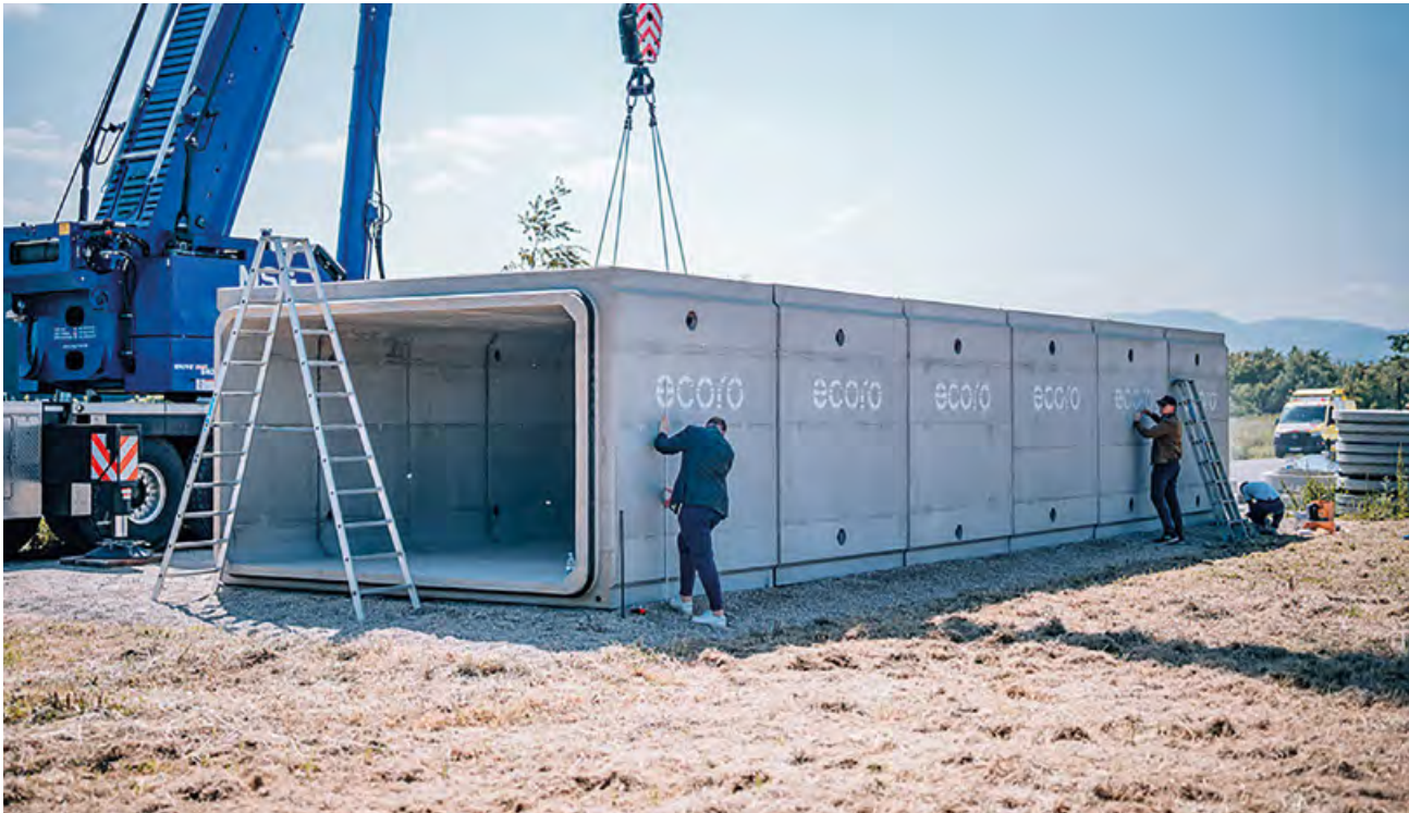
Aufbau der 15 m langen Testanlage, bestehend aus Stahlbeton-Rechteckprofilen.
